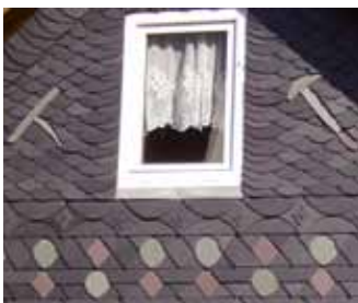
Glückaufstraße – Einsatz von farbigem Schiefer zur Gestaltung
