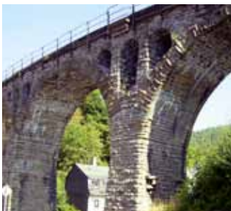
Überspannung des Tales durch Viadukt
