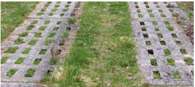
Wabenplatten im Bereich des Kolonnenweges
